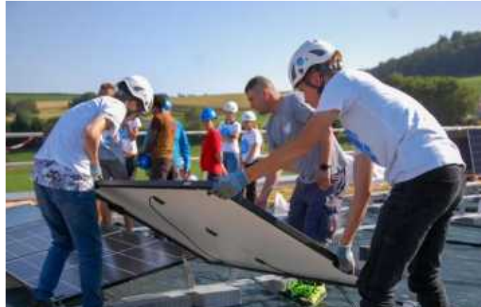
Schule beim Aufbau einer Solaranlage
